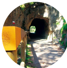
Túnel al camí dels Matxos
